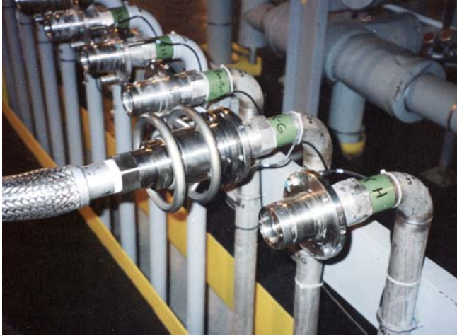
Bild 6: Reihe von elektronisch kodierten WALTHER-Kupplungen
